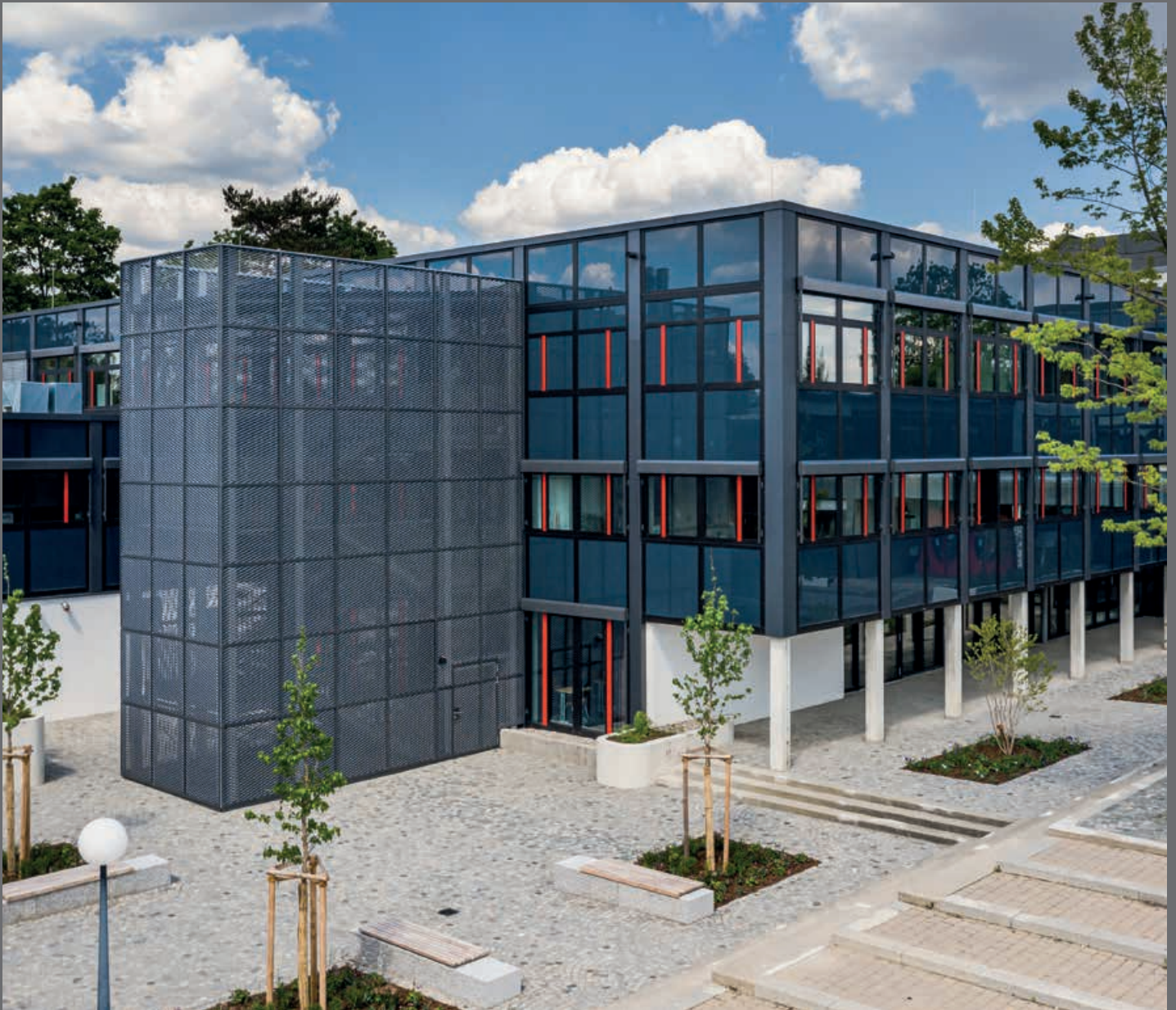
Die Außentreppe heute: seit Herbst 2019
