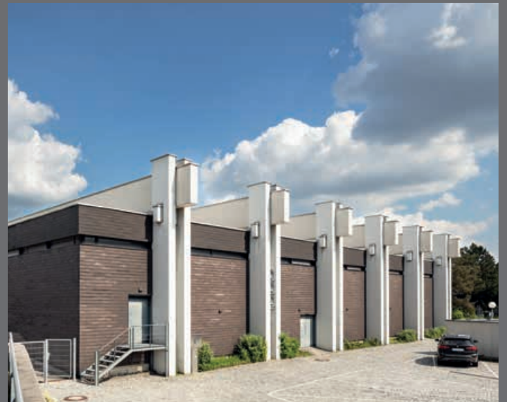
Die Westseite der Sporthalle.
